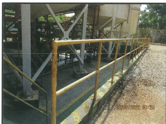
รูปที่ 11 Bund Wall ล้อมรอบบริเวณถังกักเก็บวัสดุที่ไม่ใช้แล้วที่เป็นของเหลว
