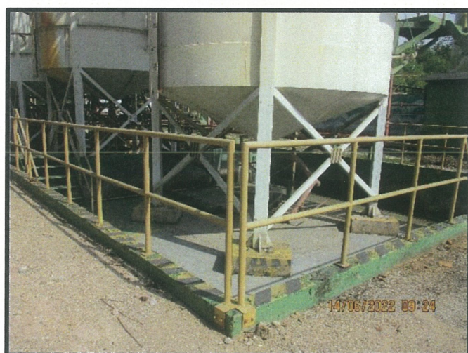
รูปที่ 11 Bund Wall ล้อมรอบบริเวณถังกักเก็บวัสดุที่ไม่ใช้แล้วที่เป็นของเหลว
