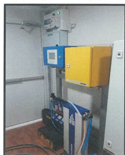
รูปที่ 5 ระบบ Continuous Monitoring Emission System (CEMs) พร้อมห้องควบคุม
