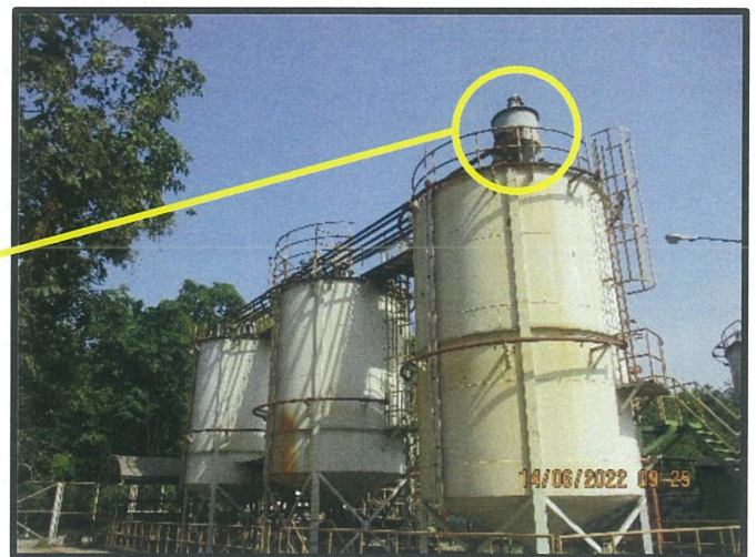
รูปที่ 7 ระบบบำบัดไอสารอินทรีย์ที่ระบายออกจากท่อระบาย (Vent)
