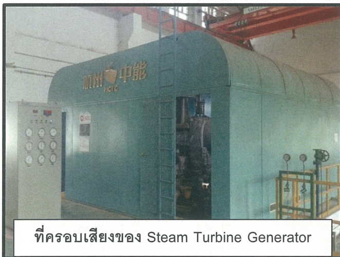
รูปที่ 24 การติดตั้งวัสดุเพื่อปิดกั้นและลดระดับเสียงภายในโครงการ
