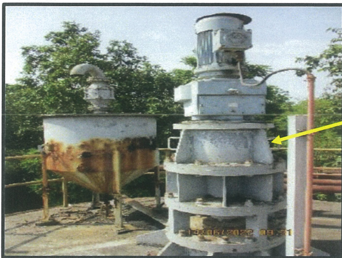
รูปที่ 7 ระบบบำบัดไอสารอินทรีย์ที่ระบายออกจากท่อระบาย (Vent)
