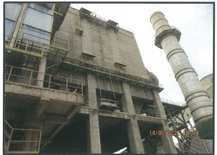
รูปที่ 2 ระบบบำบัดฝุ่นแบบไฟฟ้าสถิต (Electrostatic Precipitator)
