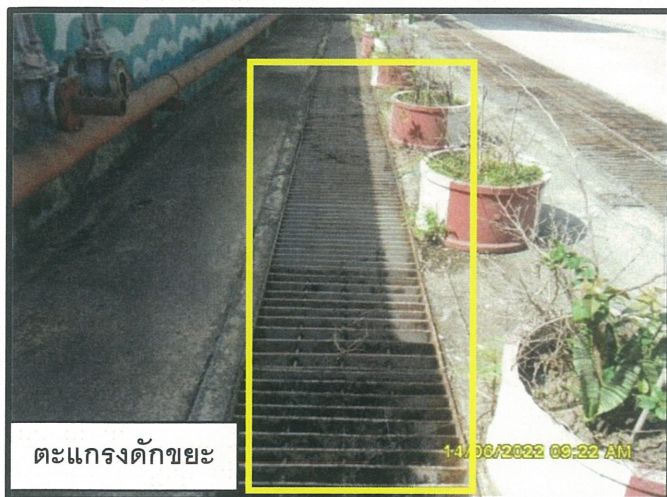
รูปที่ 10 ตะแกรงดักขยะและบ่อดักไขมัน บริเวณถังกักเก็บวัสดุที่ไม่ใช้แล้วที่เป็นของเหลว
